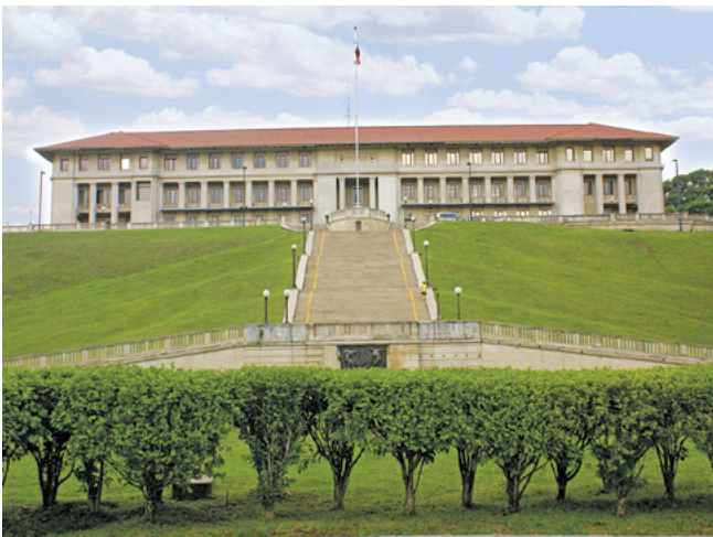
La Comisión del Canal de Panamá (Panama Commission) fue la predecesora de la Autoridad del Canal de Panamá. En la foto, el edificio de la Administración del Canal.
