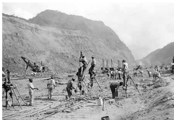
⤴ Fotografía de la construcción del Canal de Panamá en 1913.
